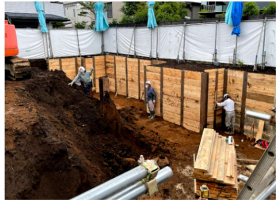
Photo1 掘削・山留工事の様子(著者撮影)
